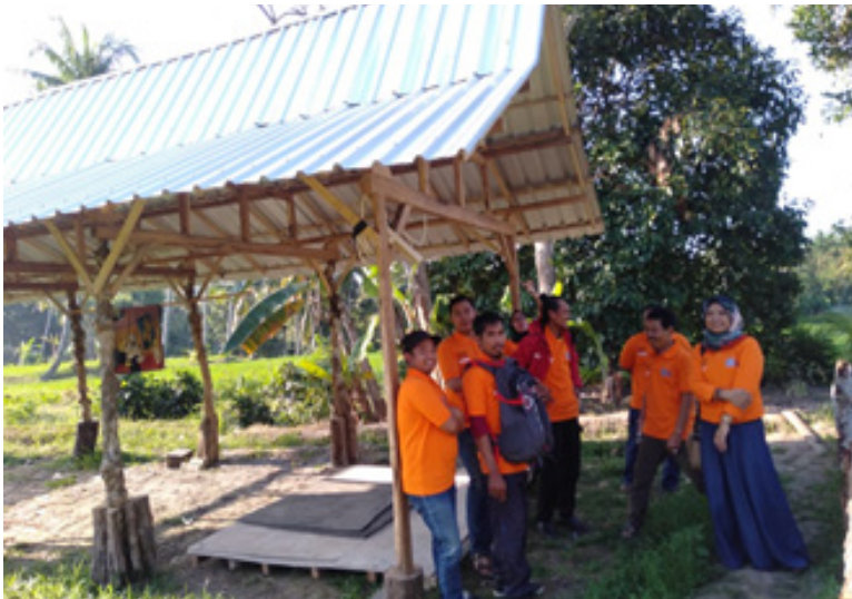
Sanggar masih dalam proses pembangunan
