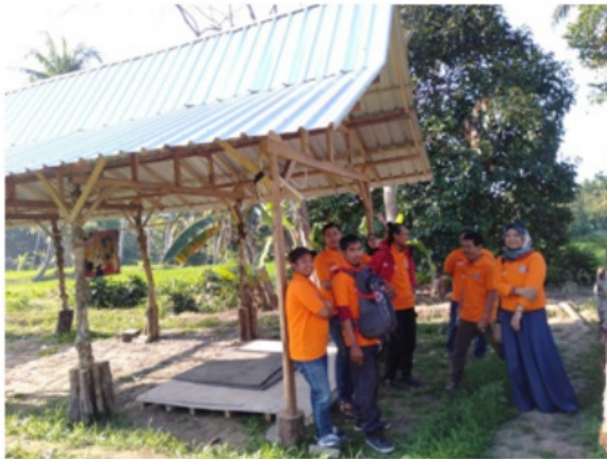
Sanggar masih dalam proses pembangunan
